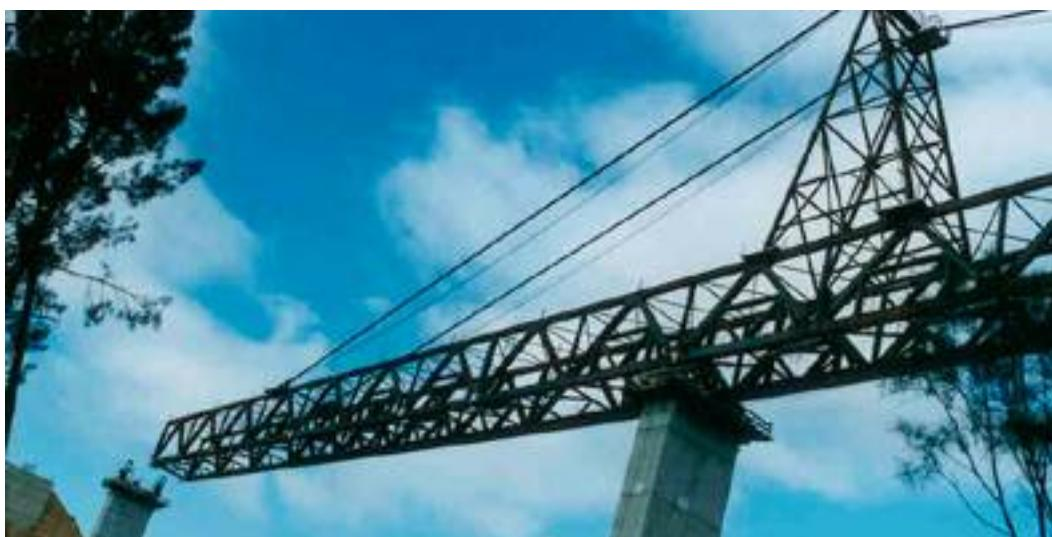
El puente sobre el río Deva se encuentra prácticamente en la confluencia entre este cauce y el río Miño, próximo a la presa de Filgueira, por lo que no hay variación de nivel, lo que determinó la longitud del vano central de la estructura, en evitación de dicho cauce del Deva, donde la profundidad alcanza los 36 m.
